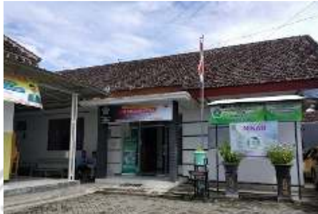
Gambar 1. Gedung KUA Mojoroto
